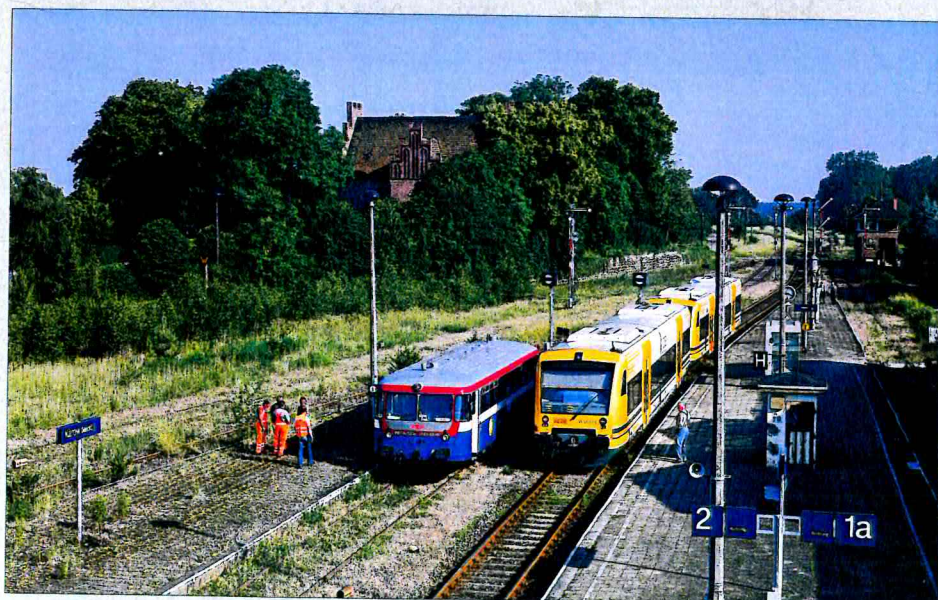
Zehn Jahre später, am 7. Juni 2007, muss man zu einer anderen Einschätzung kommen: Die links im Bild befindlichen Gleise 4 und aufwärts sind allenfalls noch zu erahnen, gleichwohl sie wenigstens teilweise noch in Betrieb sind. Über Gleis 2 wird der verbliebene Regelverkehr abgewickelt – im Bild 650.53 und 653.75 der ODEG als OE 80376 (Neustrelitz Hbf – Hagenow). Der PEG-Schienenbus T 11 wird in Kürze von Gleis 3 nach Priemerburg starten, um Mitarbeiter der Infrastruktur mit den Örtlichkeiten dieser Strecke vertraut zu machen.
