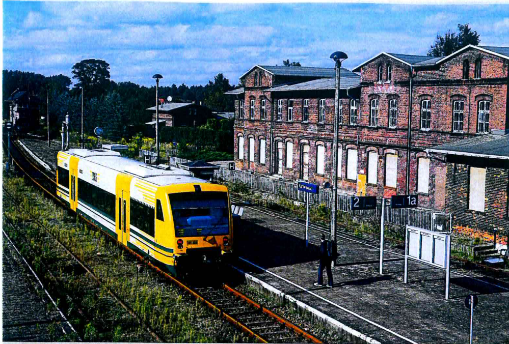
Auch das warme Nachmittagslicht des 6. September 2007 kann nicht kaschieren, dass das stattliche Empfangsgebäude des Bahnhofs Karow schon bessere Zeiten gesehen hat. Völlig leer stehend und „verriegelt und verrammelt“ ist es sich selbst überlassen. Fahrgäste, die die noch verbliebenen ODEG-Züge – im Bild 650.52 als OE 80394 – nutzen wollen, werden um das Gebäude herum geleitet, um den Bahnsteig 2 betreten zu können.
